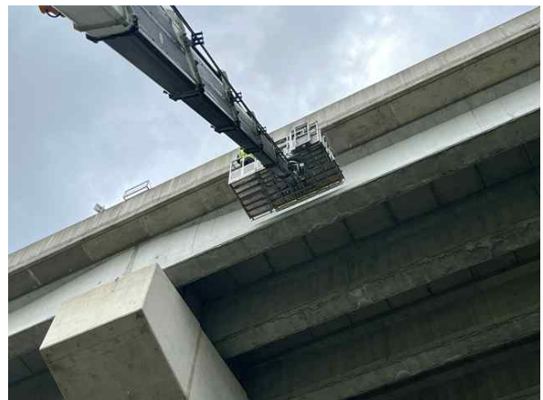
고소점검차를 이용한 근접조사
