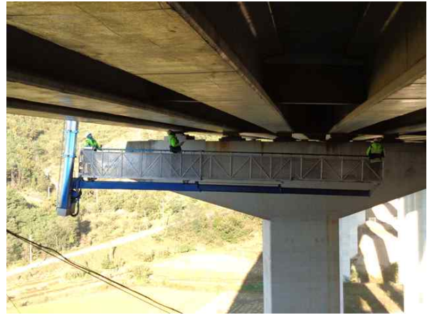
굴절점검차를 이용한 근접조사
