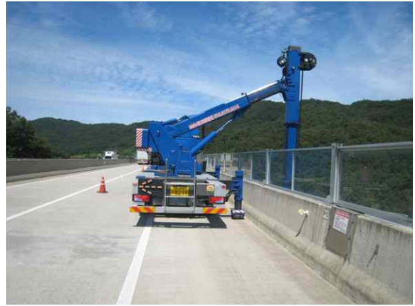
굴절점검차를 이용한 근접조사
