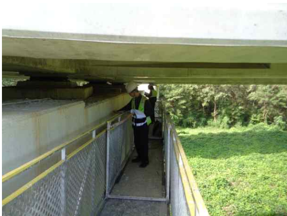
굴절점검차를 이용한 근접조사
