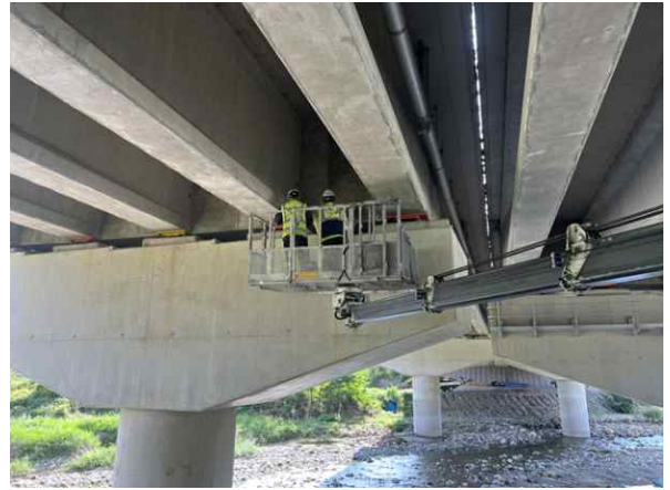
고소점검차를 이용한 근접조사
