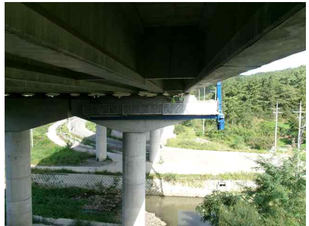
굴절점검차를 이용한 근접조사
