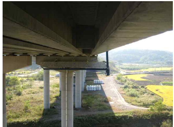
교량점검차를 이용한 근접조사
