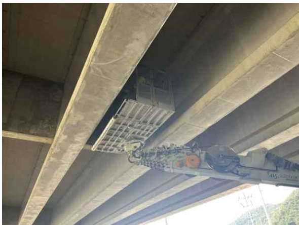
고소점검차를 이용한 근접조사
