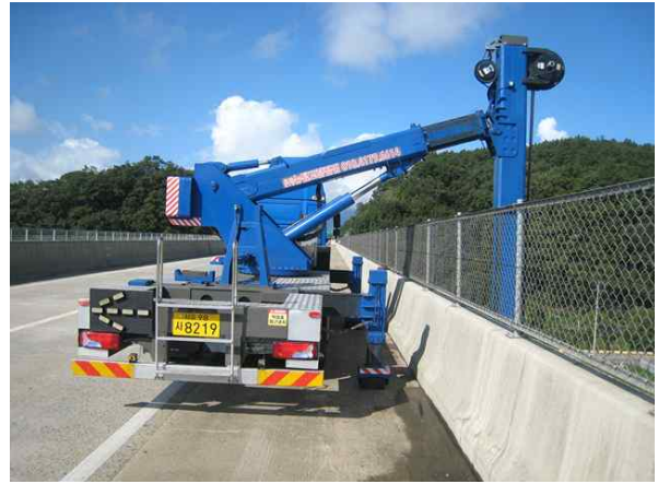
교량점검차를 이용한 근접조사
