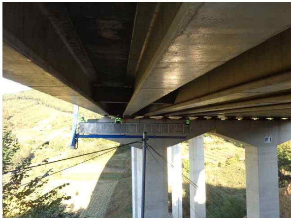
굴절점검차를 이용한 근접조사
