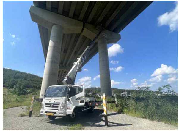
고소점검차를 이용한 근접조사
