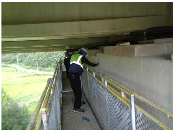
굴절점검차를 이용한 근접조사
