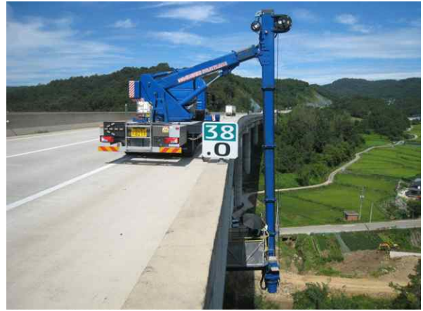
굴절점검차를 이용한 근접조사
