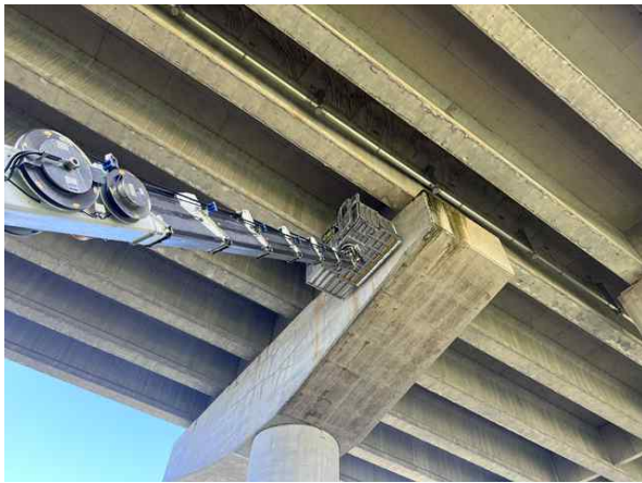
고소차를 이용한 근접조사
