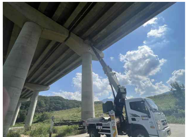
고소점검차를 이용한 근접조사
