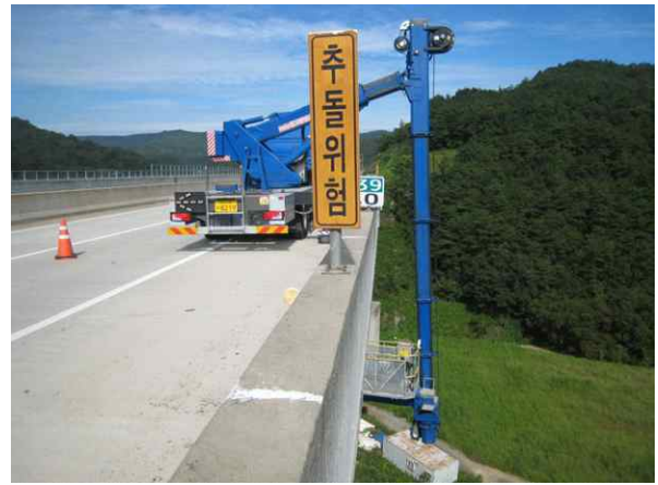
굴절점검차를 이용한 근접조사
