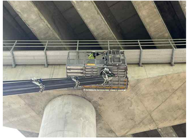
고소점검차를 이용한 근접조사
