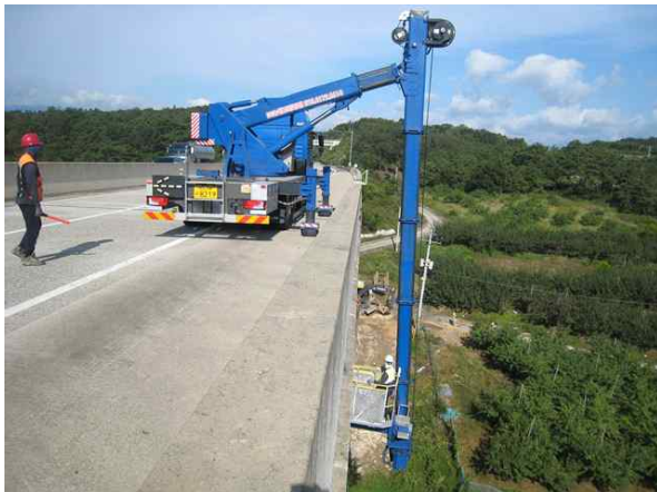
교량점검차를 이용한 근접조사
