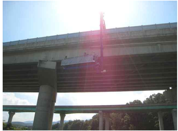
교량점검차를 이용한 근접조사
