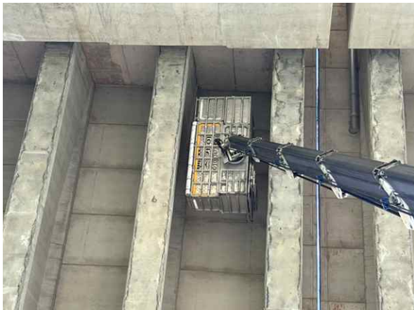
고소점검차를 이용한 근접조사
