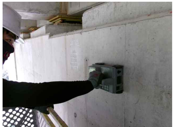
교량점검차를 이용한 근접조사
