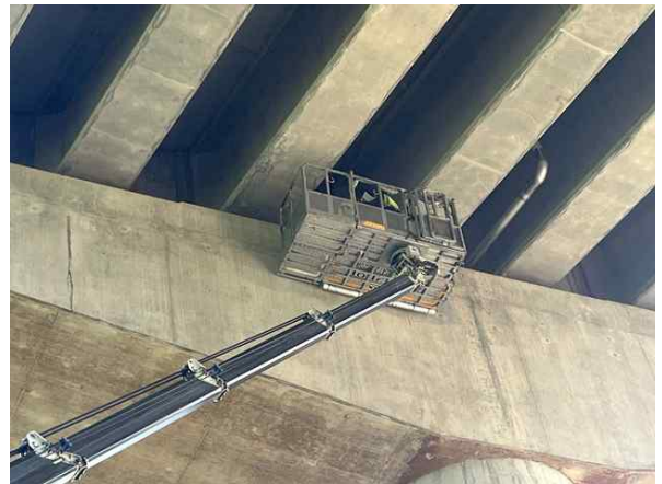
고소점검차를 이용한 근접조사
