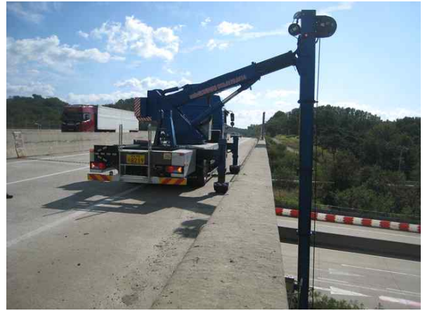
굴절점검차를 이용한 근접조사
