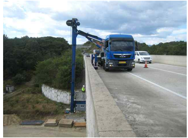
교량점검차를 이용한 근접조사
