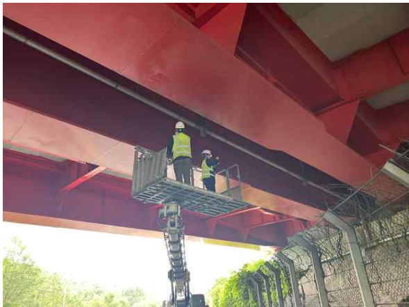
고소차를 이용한 근접조사
