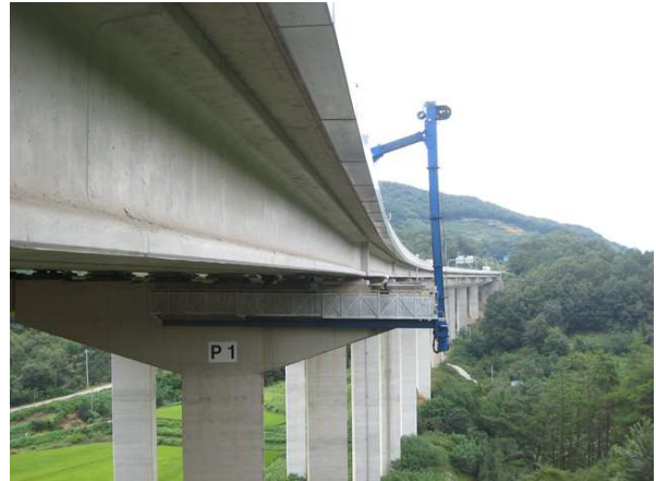
굴절점검차를 이용한 근접조사
