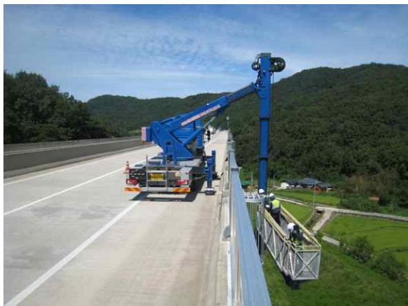
굴절점검차를 이용한 근접조사
