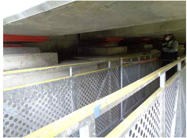
굴절점검차를 이용한 근접조사
