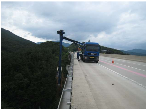
굴절점검차를 이용한 근접조사
