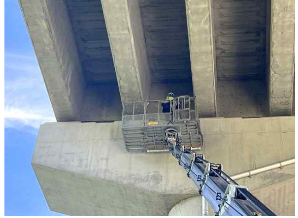
고소차를 이용한 근접조사
