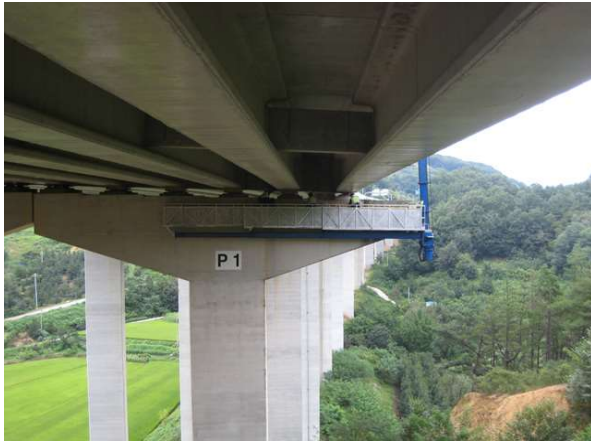
굴절점검차를 이용한 근접조사
