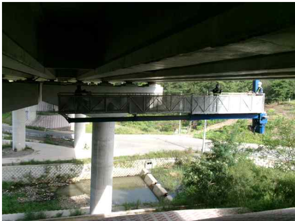
굴절점검차를 이용한 근접조사
