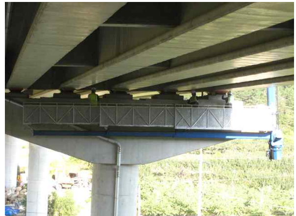
교량점검차를 이용한 근접조사
