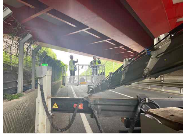
고소차를 이용한 근접조사
