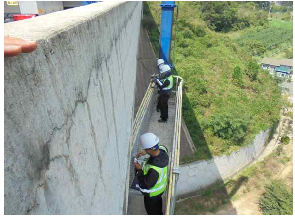
교량점검차를 이용한 근접조사
