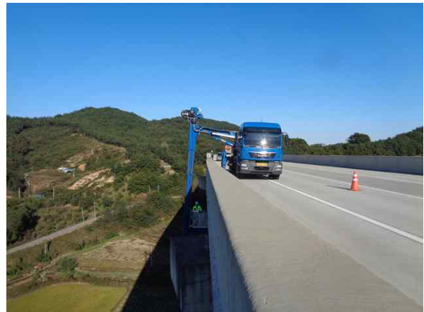
굴절점검차를 이용한 근접조사
