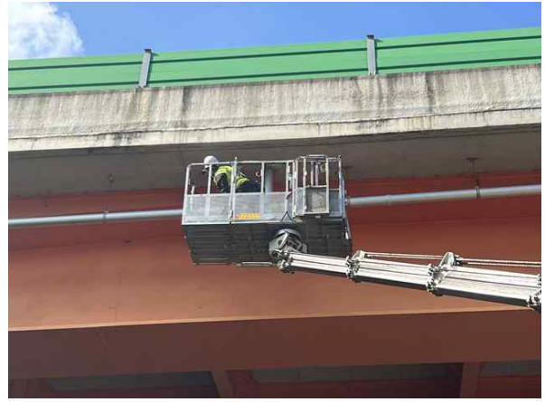
고소점검차를 이용한 근접조사
